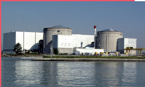
Centrale nucléaire de Fessenheim Crédit photo : Florival fr
